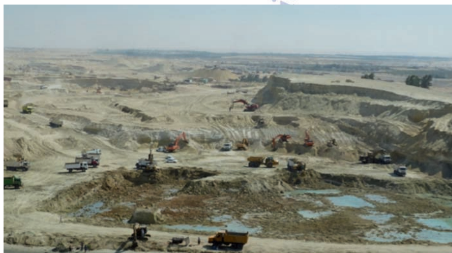
Travaux de doublement des voies du Canal de Suez.
