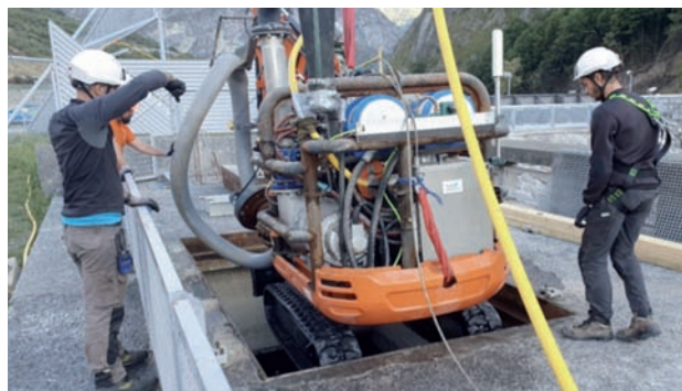
Lisie® grutée dans un tunnel de prise d'eau par une trappe à Jeep.
