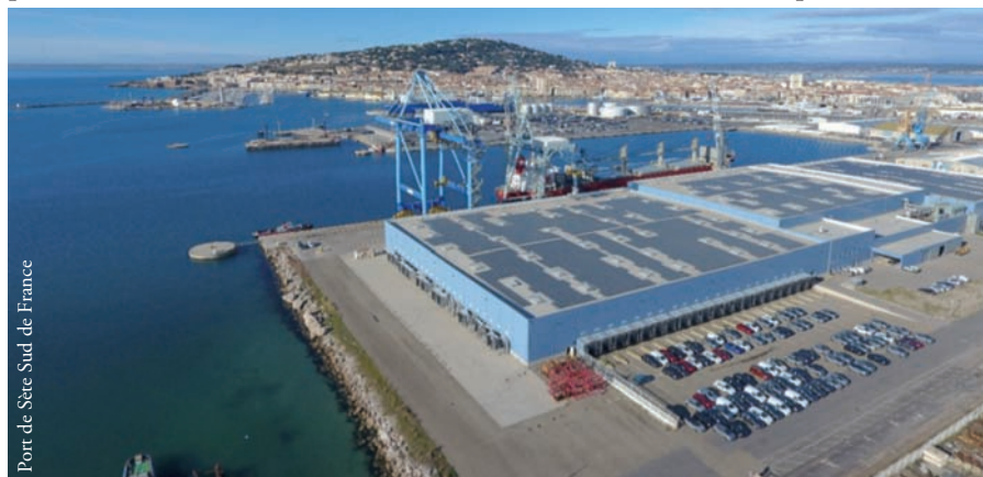
Couverture photovoltaïque du terminal frigorifique
