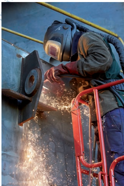
Campus des industries navales
