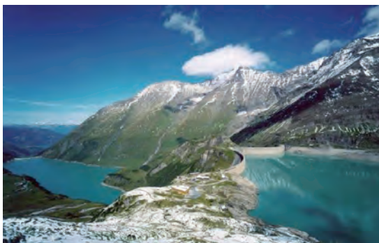
Bassins haut et bas de la STEP de Limberg II, Autriche. Source : VoithHydro
