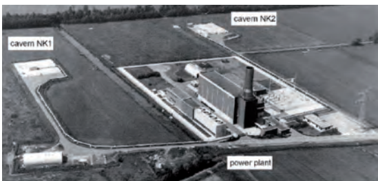
Usine de stockage pneumatique de Huntorf (290 MW) en Allemagne
